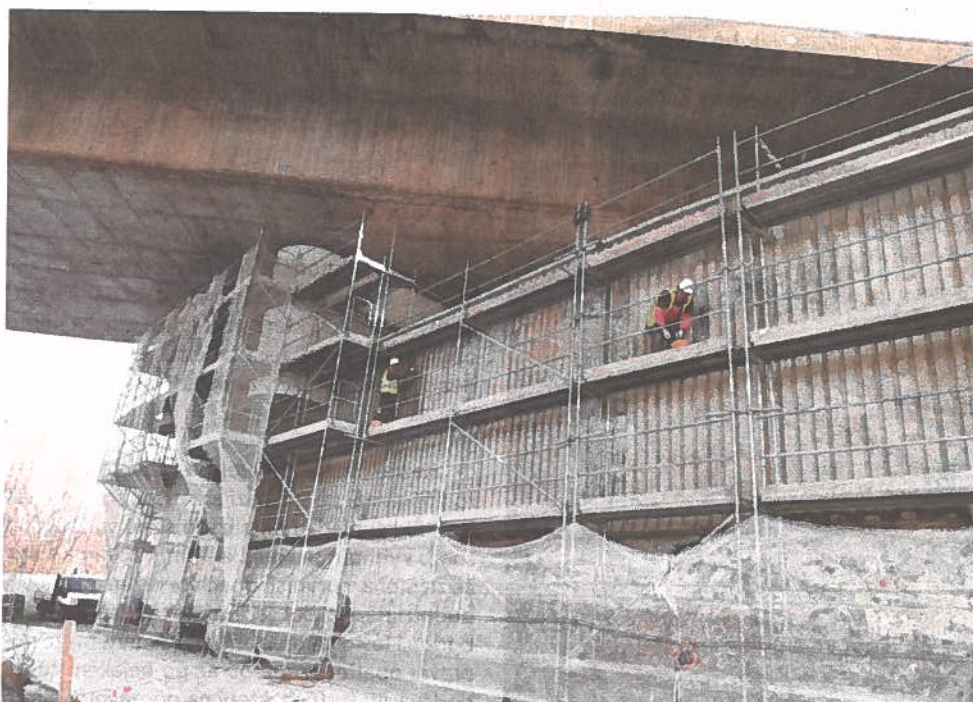
Rok 2021: Oprava pilířů a sanace konstrukce spodní stavby mostu.
