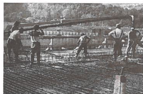
Na výstavbě mostu se podílela skupina polských tesařů.
