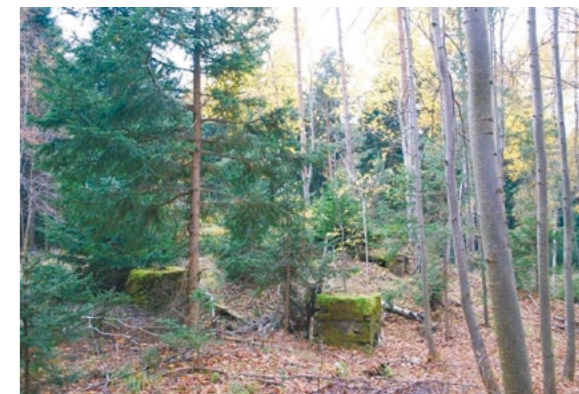
Opěrné betonové patky těžní věže uranové šachty JD 50 u Kytína, za nimi homole kamení na ústí šachty (2014).
